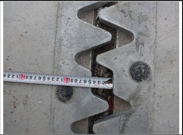
신축이음 원주방향 A1 유간 측정
