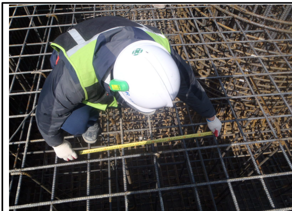
P3 기초 철근 배근 간격 측정 (서울방향)
