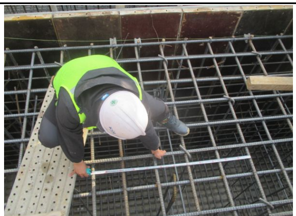
P1 기초 철근 배근 상태 확인 (원주방향)
