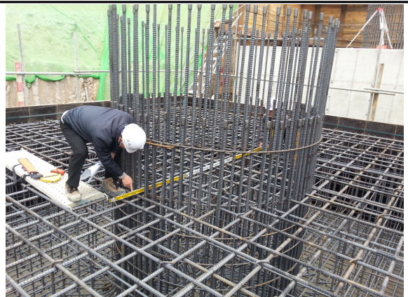
P1 기초 철근 배근 간격 측정 (원주방향)
