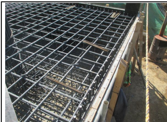
P2 기초 철근 배근 간격 측정 (서울방향)
