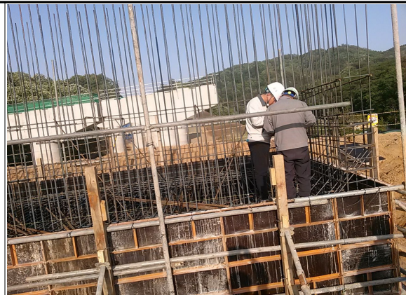
A1 기초 시공 상태 검측 (원주방향)
