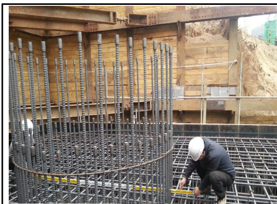
P1 기초 철근 배근 간격 측정 (서울방향)
