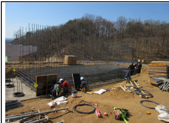
A2 기초 시공 상태 (서울방향)
