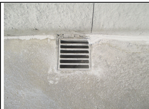
배수구 시공 상태 점검(서울방향)
