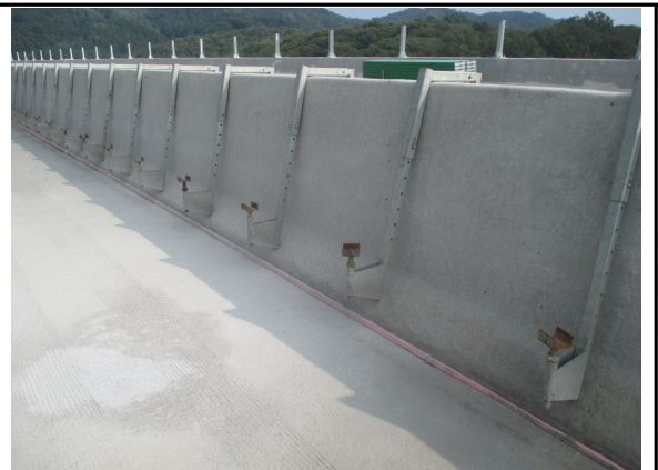
방호벽 시공 상태 점검(서울방향)
