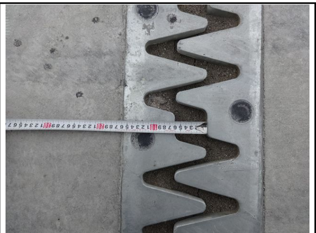
신축이음 서울방향 A2 유간 측정
