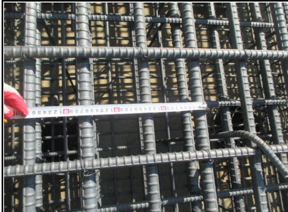
A1 기초 철근 배근 상태 확인 (원주방향)
