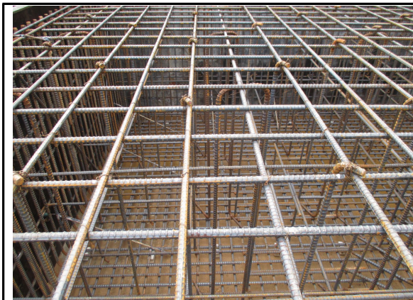
P5 기초 철근 조립 상태 (원주방향)
