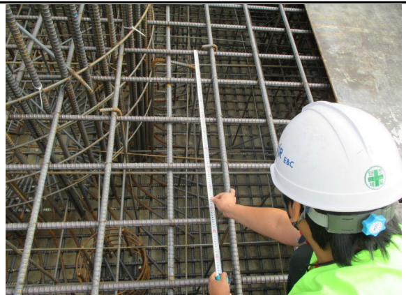
P1 기초 철근 배근 상태 확인 (서울방향)
