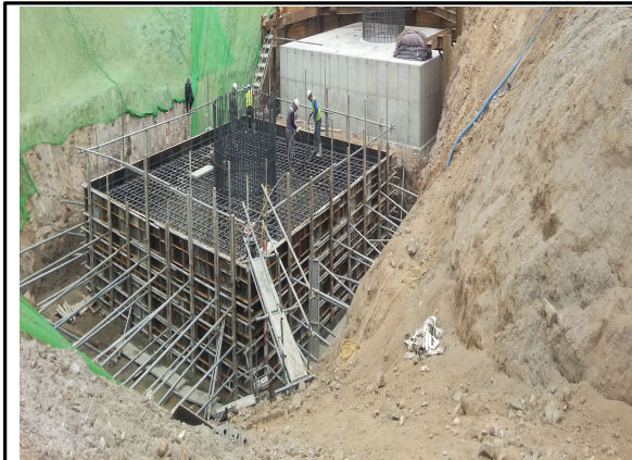
P1 기초 시공 현황 (원주방향)
