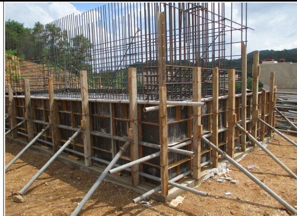
A1 기초 시공 현황 (원주방향)
