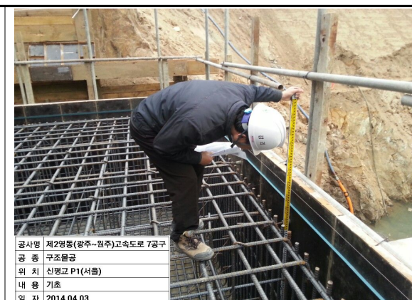
P1 기초 시공 상태 검측 (서울방향)
