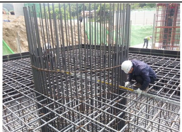
P2 기초 철근 배근 간격 측정 (서울방향)
