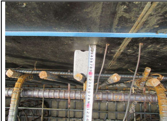
P1 기초 피복 시공 상태 측정 (서울방향)
