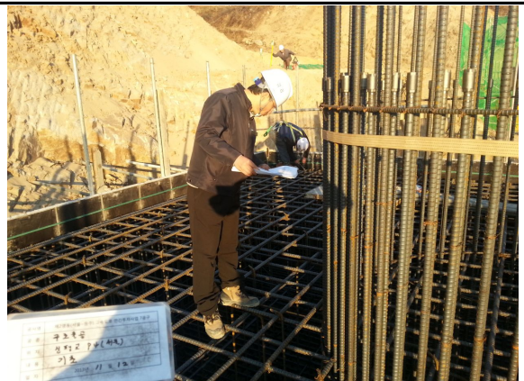
P4 기초 시공 상태 검측 (서울방향)
