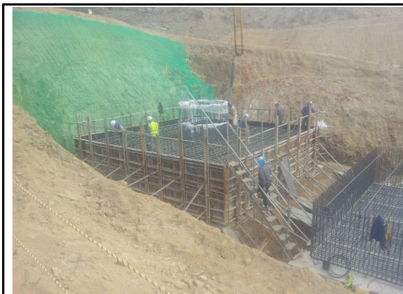
P5 기초 시공 현황 (서울방향)
