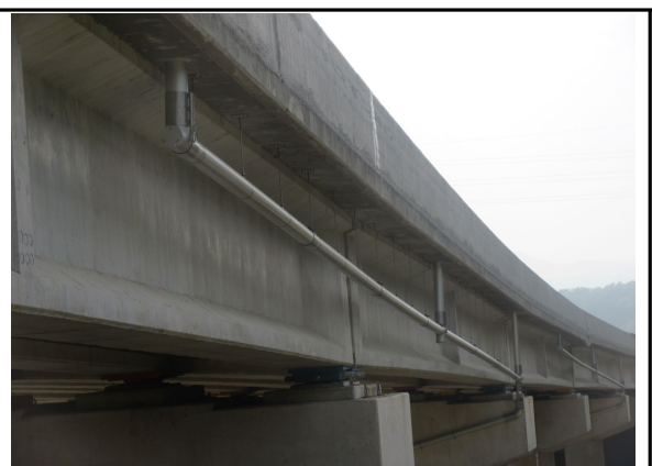
배수관 시공 상태 전경(서울방향)
