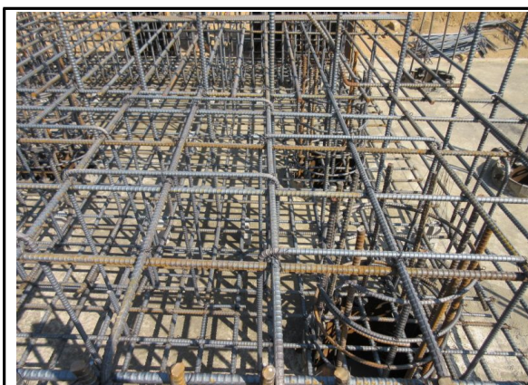
A2 기초 시공 상태 (서울방향)
