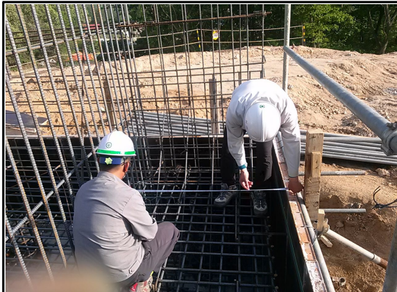
A1 기초 시공 상태 검측 (원주방향)
