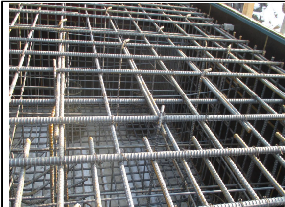
P4 기초 철근 조립 상태 (서울방향)
