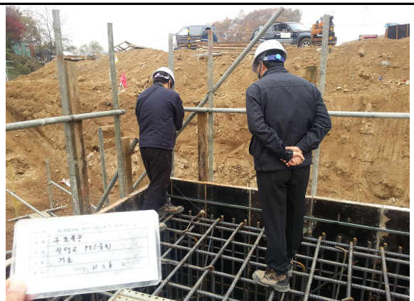
P5 기초 시공 상태 검증 (원주방향)
