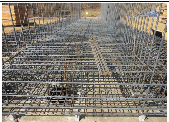
A2 기초 시공 상태 (서울방향)
