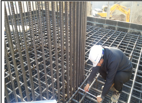
P4 기초 철근 배근 간격 측정 (원주방향)
