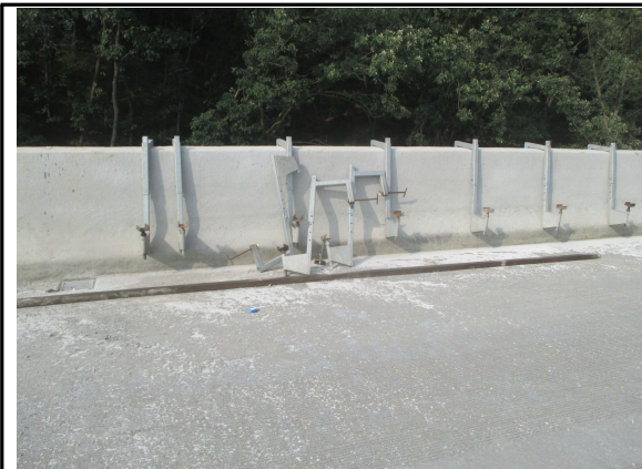
방호벽 시공 상태 점검(서울방향)
