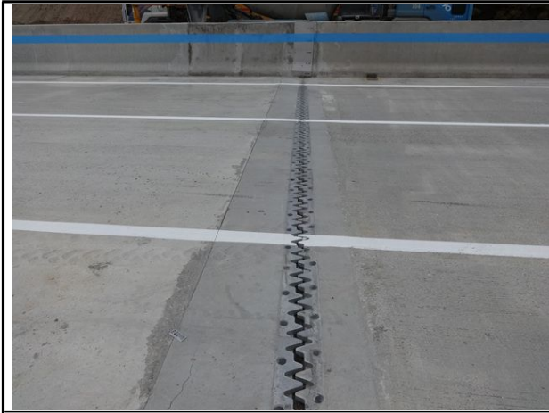
신축이음 원주방향 A1 전경
