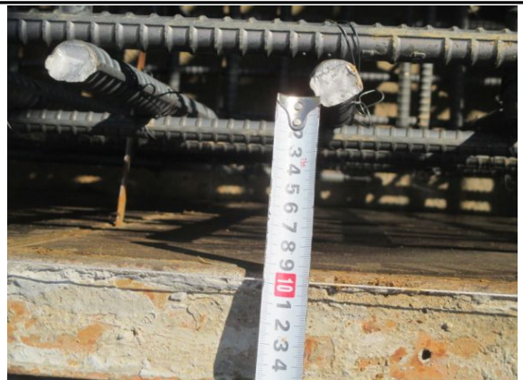
P2 기초 철근 피복 측정 확인 (원주방향)
