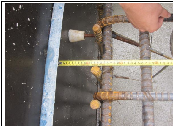
P1 기초 피복 시공 상태 측정 (원주방향)
