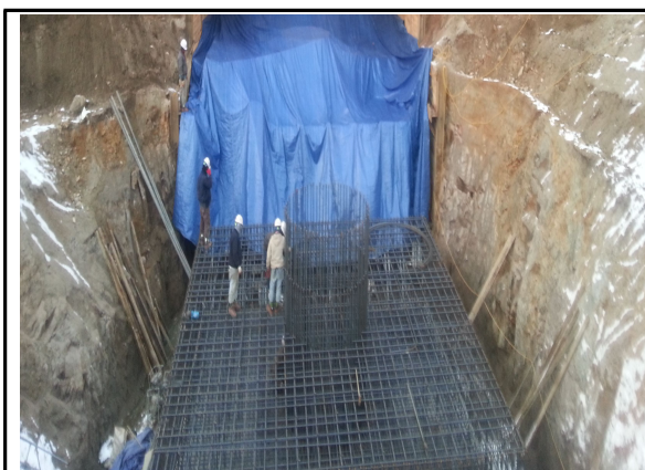
P3 기초 시공 현황 (원주방향)
