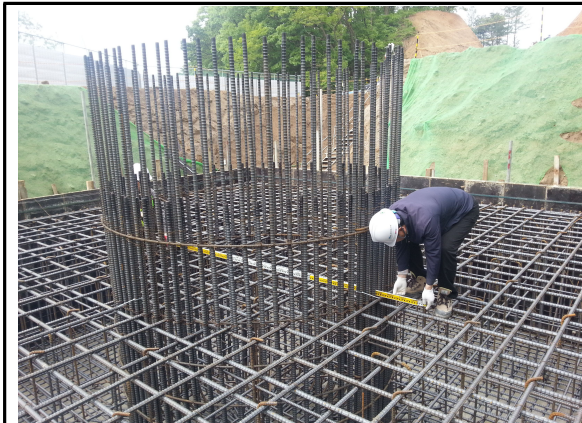
P2 기초 철근 배근 간격 측정 (원주방향)
