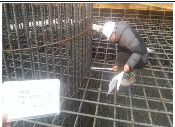
P3 기초 시공 상태 검측 (서울방향)
