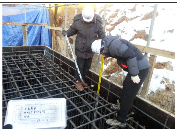
P3 기초 시공 상태 검측 (원주방향)
