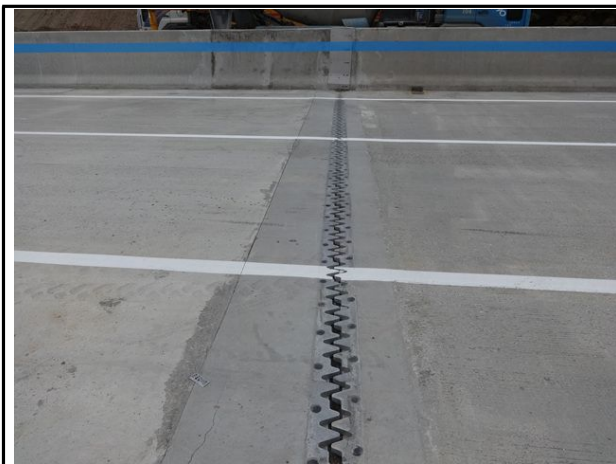
신축이음 원주방향 A1 전경
