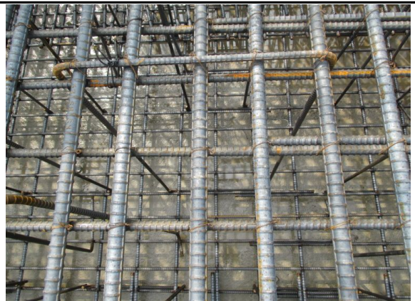
P2 기초 시공 상태 (원주방향)
