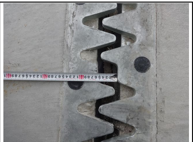
신축이음 원주방향 P3 유간 측정
