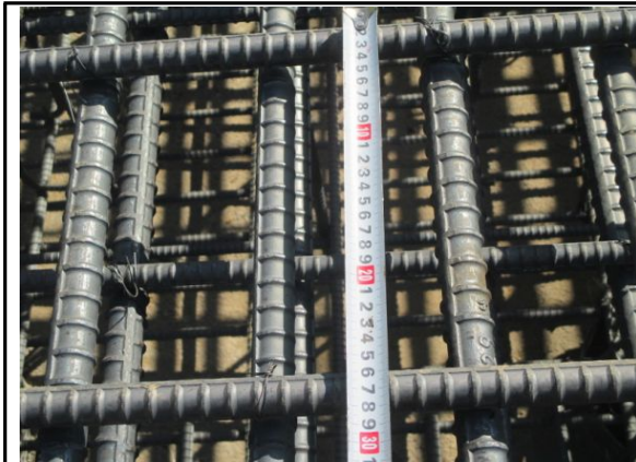
P2 기초 철근 배근 간격 측정 (원주방향)
